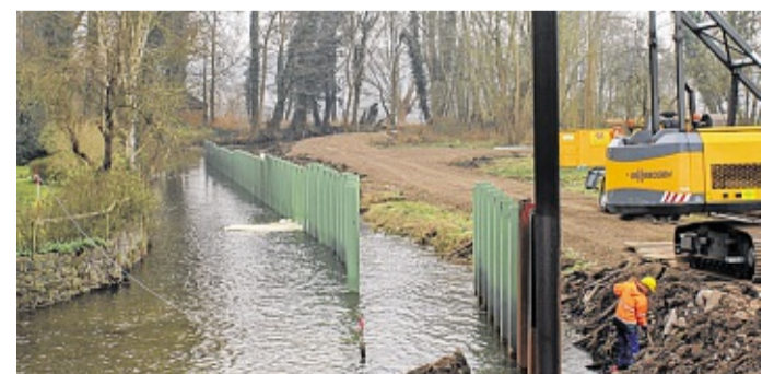
Die beiden Seiten der Wariner Fischtreppe zwischen den Stahlpundbohnen zeichnet sich bereits ab. FOTOS: ROLAND GÜTLER
